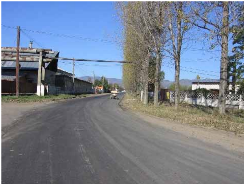
REFACERE DRUMURI ASFALTATE
