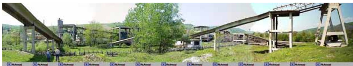
CERNA inainte de inceperea lucrarilor
