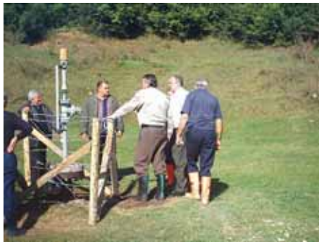
Mina BEREVOIESTI la finalizarea lucrarilor
