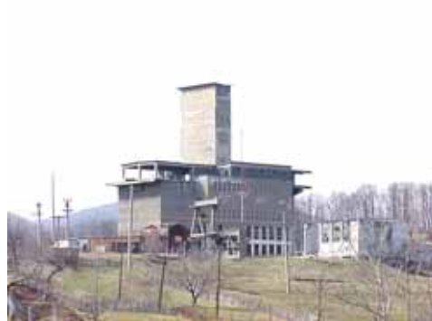
Mina BEREVOIESTI - turnul putului - inainte de inceperea lucrarilor
