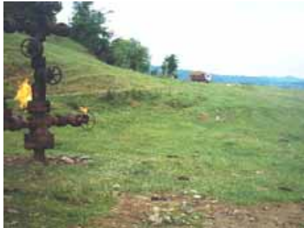
Mina BEREVOIESTI inainte de inceperea lucrarilor
